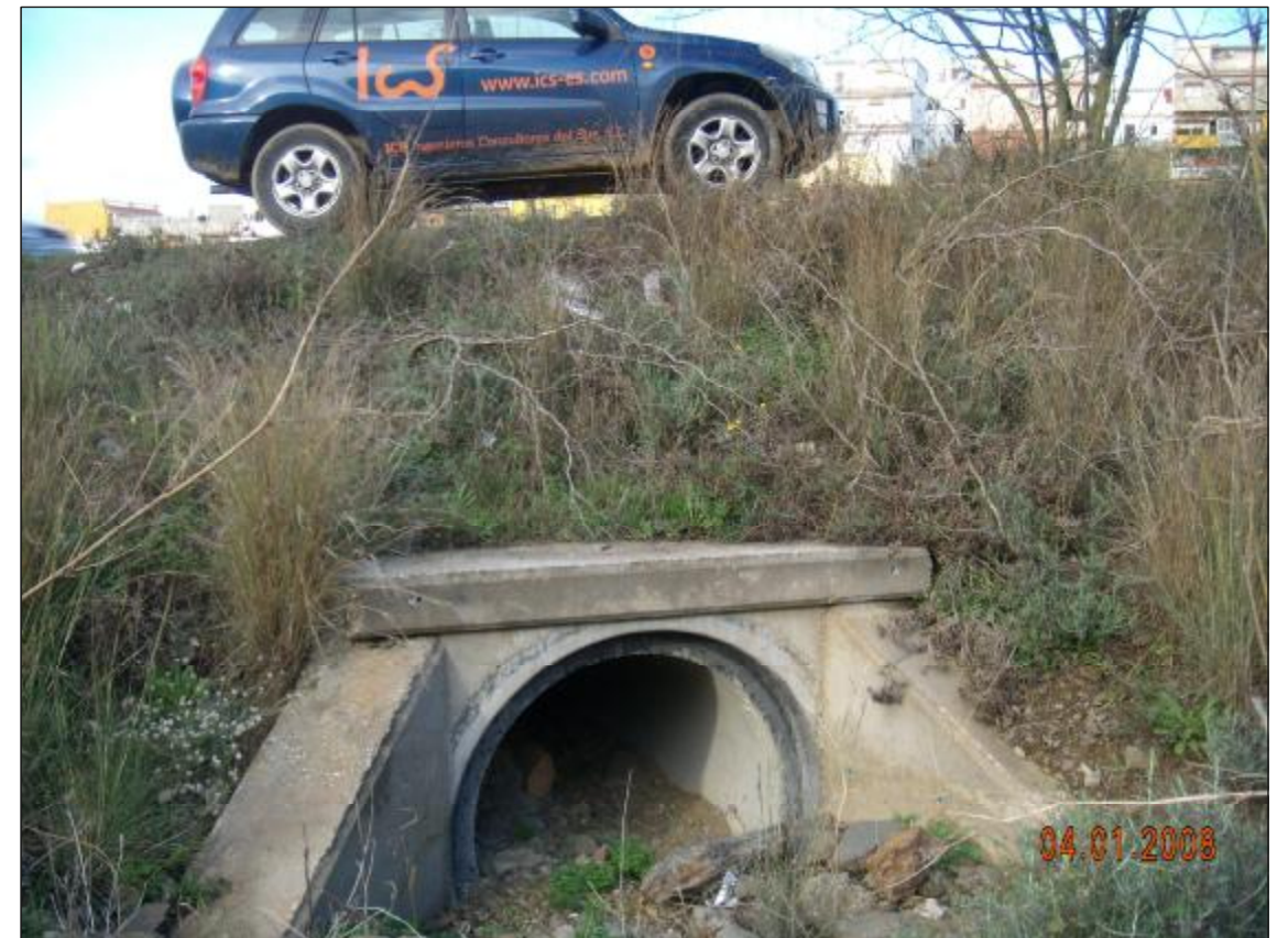
Fotografía nº 24. - La obra de drenaje transversal, de un metro de diámetro, demuestra lo comentado en la fotografía anterior.
