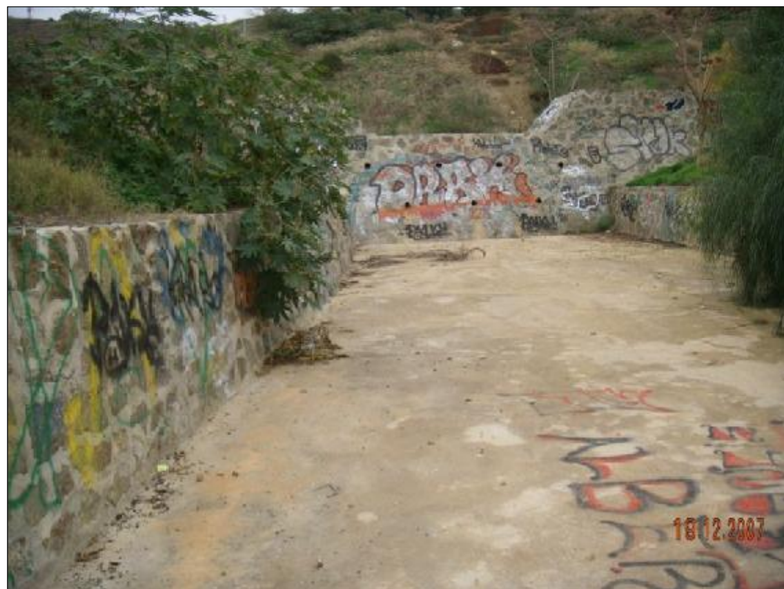
Fotografía nº 3. - Al fondo, mirando hacia aguas arriba vemos un azud que limita una balsa de acarreos.
