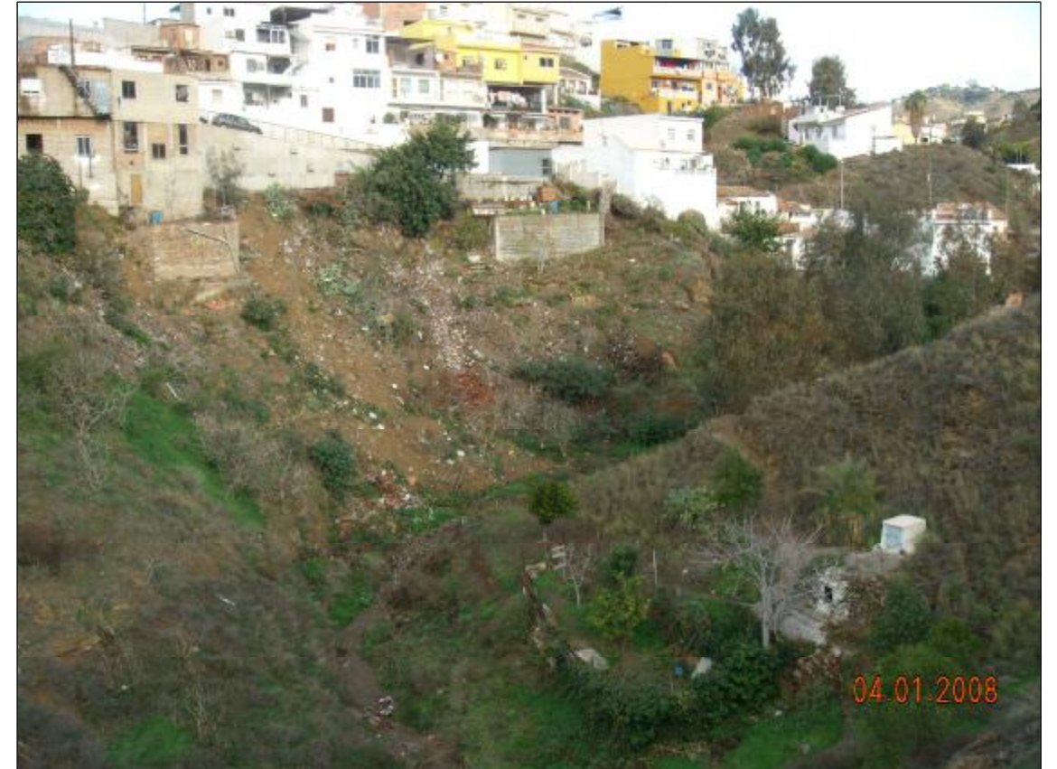
Fotografía nº 22. - Nos desplazamos por la vía que une Ciudad Jardín con la Circunvalación. Desde su margen oeste tomamos esta fotografía del Aceiteros. Observamos la fuerte pendiente de los taludes y las viviendas tradicionales situadas en su margen oeste.
