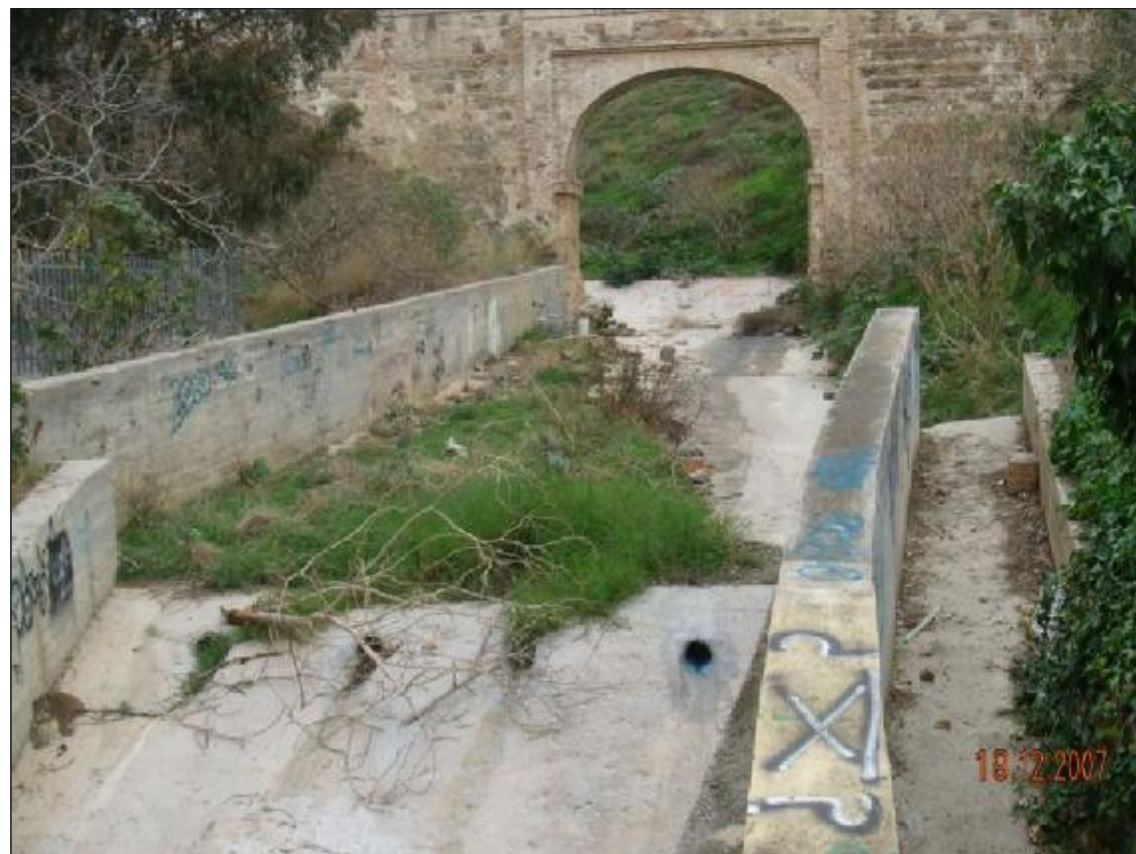
Fotografía nº 1. - De nuevo vemos el acueducto que nos hemos encontrado en varios arroyos de esta zona de Málaga. Estamos en la zona de embocadura del encauzamiento del arroyo Aceiteros.
