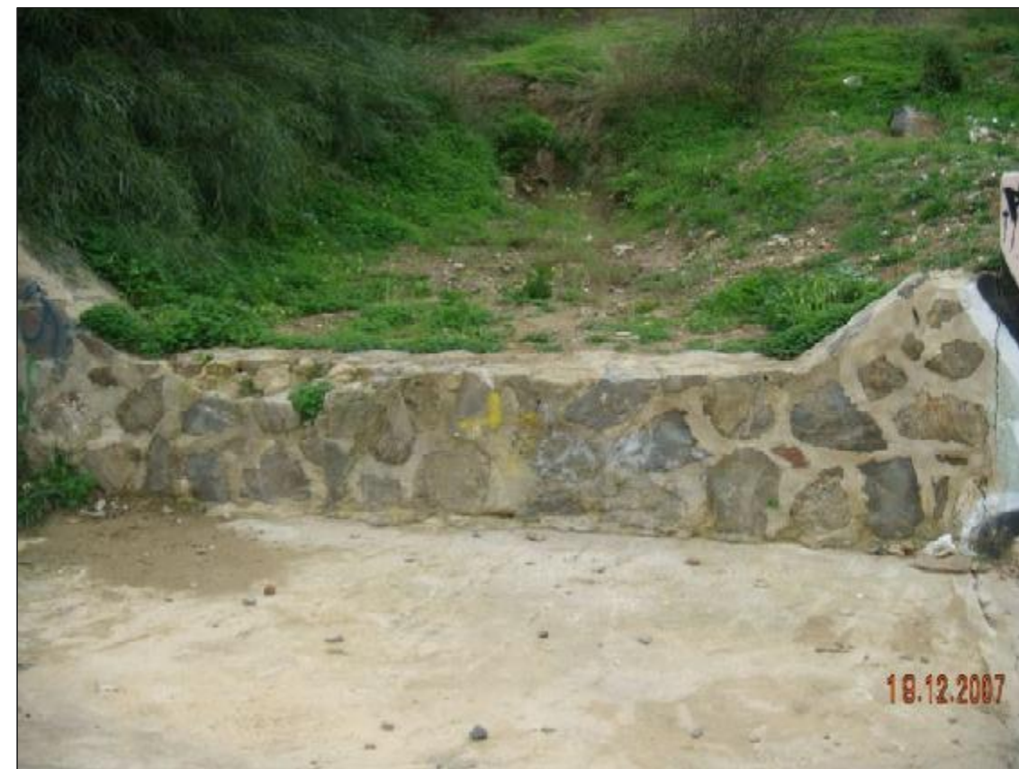
Fotografía nº 2. - Observamos como a la obra de embocadura le llega un cauce transversal de no excesiva importancia.
