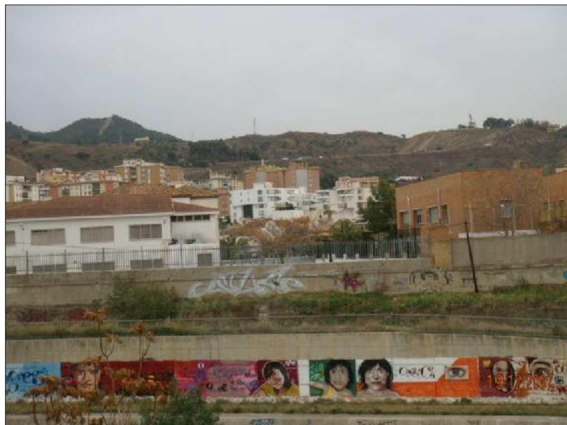
Fotografía nº 7. - Hemos vuelto a la margen izquierda del Guadalmedina, desde aquí vemos el terraplén de la A-7 a cuyo pie se encuentra el cauce que hemos recorrido del arroyo Quintana.
