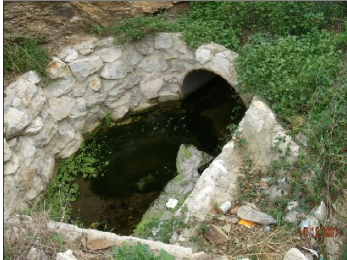
Fotografía nº 21. - Al otro lado del ramal vemos como el agua que "perseguiamos" y consiguientemente su cauce, sigue la misma dirección del antiguo cauce, por lo que nos quedamos convencidos de que el área vertiente que buscamos se implanta al oeste de la carretera de Los Montes.
