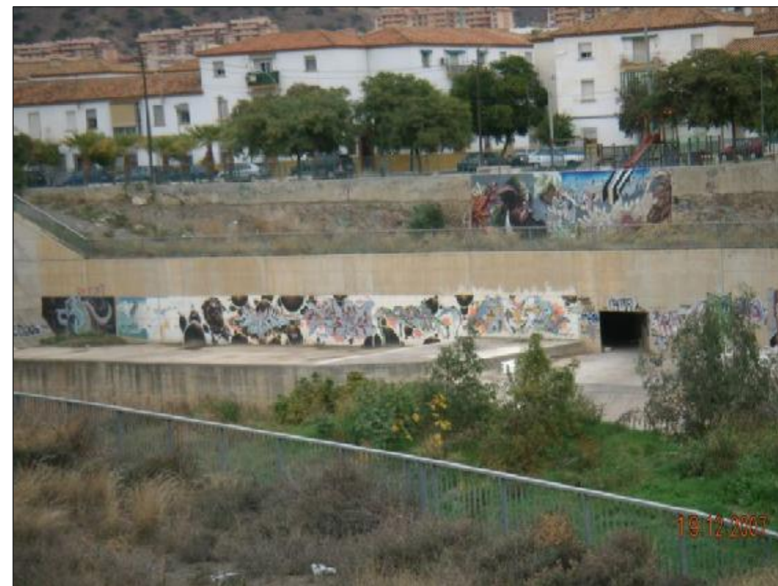
Fotografía nº 8. - Entendemos que esta salida al Guadalmedina es el final del encauzamiento del arroyo Quintana.
