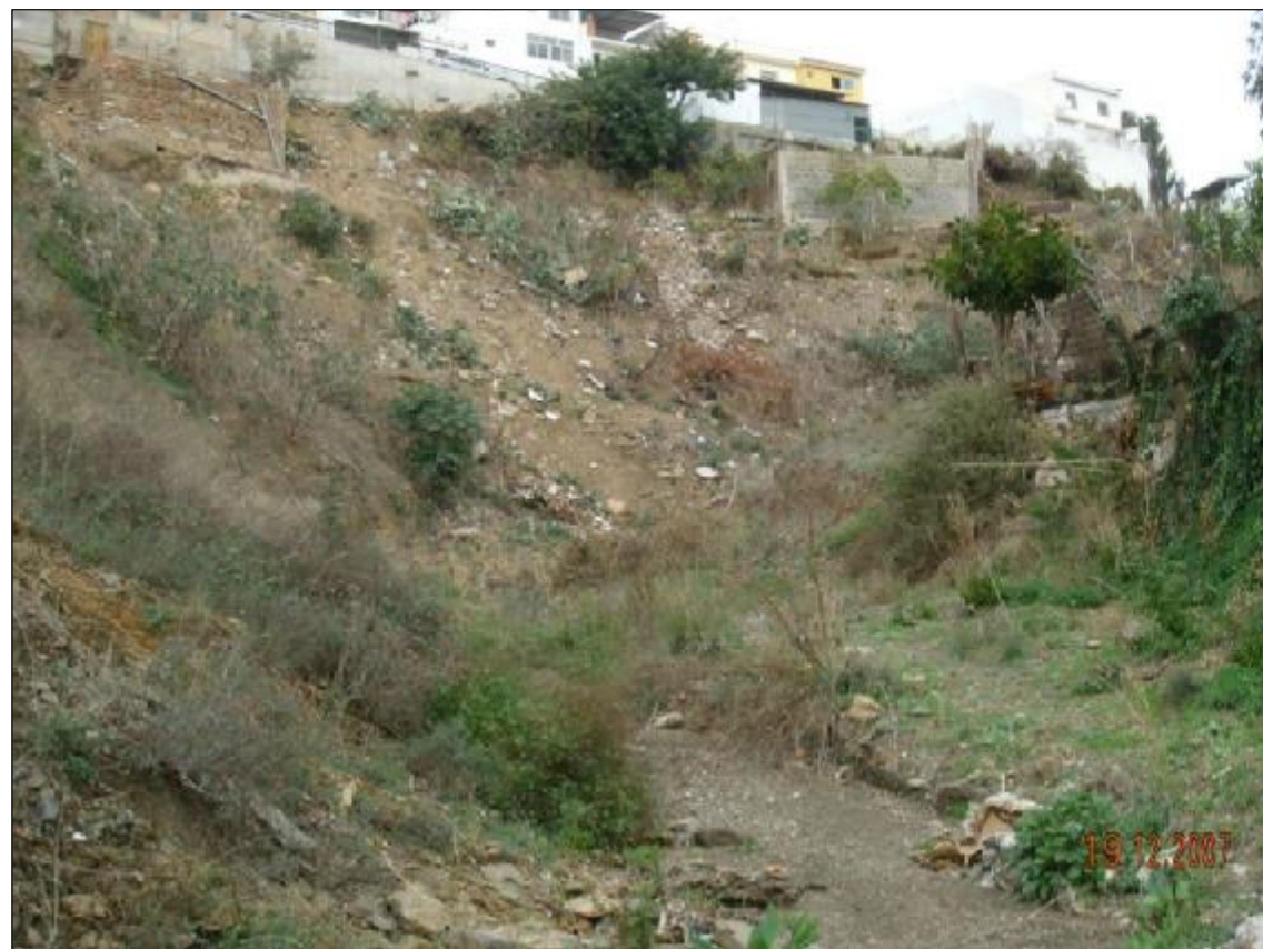
Fotografía nº 5. - Mirando hacia aguas arriba ya percibimos la barriada de viviendas tradicionales que nos acompañará en una buena parte de nuestro recorrido. El cauce sigue manteniendo una buena definición.
