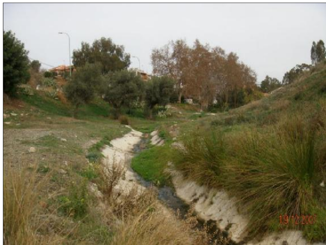
Fotografía nº 19. - Hemos descendido por la carretera de Los Montes. El arroyo que "perseguiamos" se encuentra al sureste de esa posición. Descendemos hacia el ramal de la A-7 que desciende hacia Ciudad Jardín y vemos como se conforma con una cuneta triangular que transporta alguna escorrentía.
