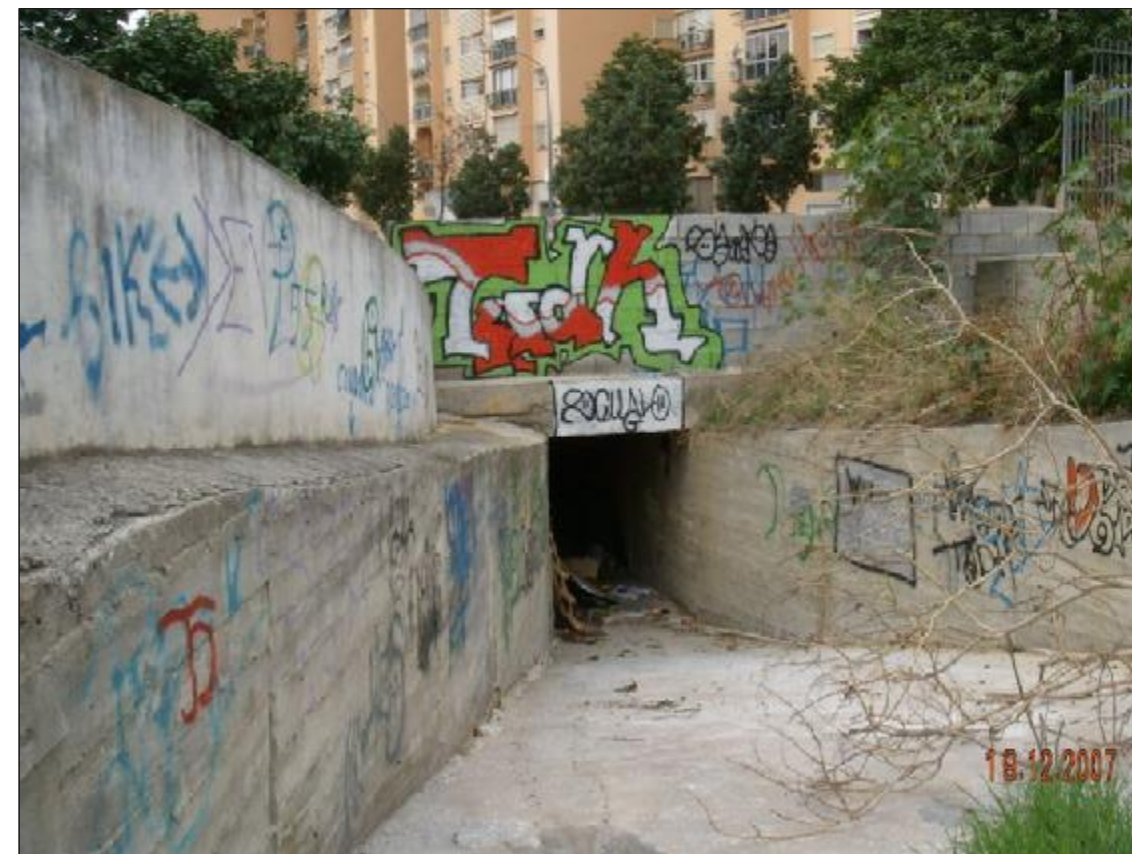
Fotografía nº 2. - Volviendo la cámara vemos la boquilla de entrada. El embovedado lo constituye un marco rectangular de 1,50 m de anchura y 2,00 m de altura.
