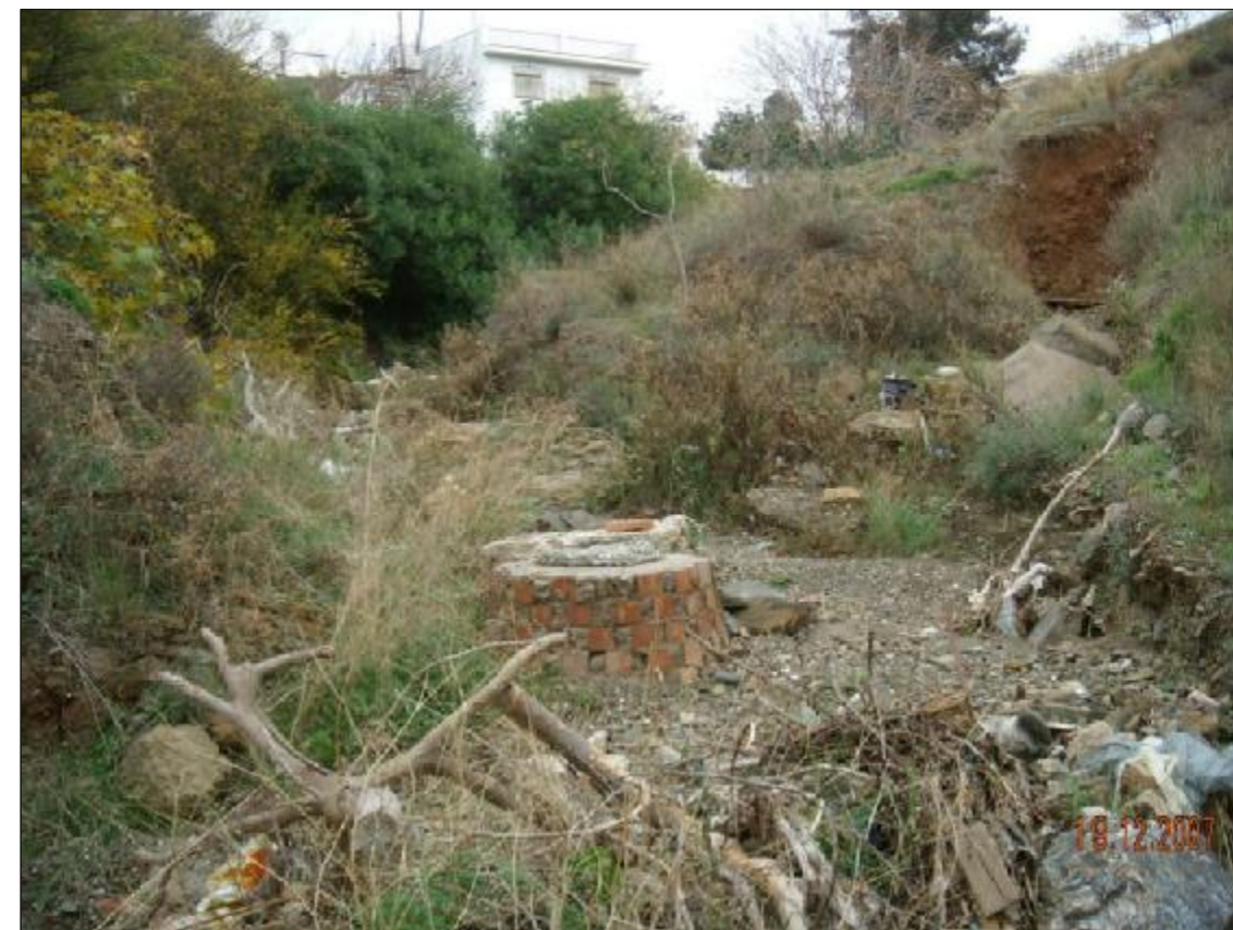
Fotografía nº 6. - En el próximo cambio de alineación miramos hacia aguas arriba, la suciedad de este cauce no nos sorprende, en todos los que hemos recorrido el problema es similar.
