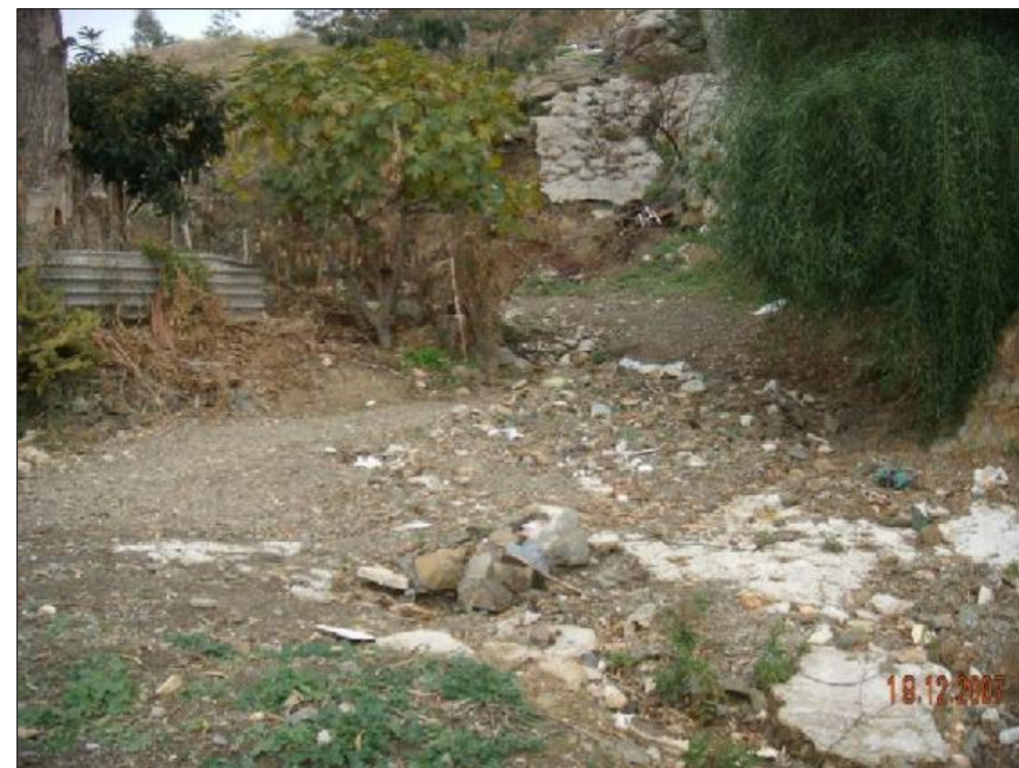
Fotografía nº 8. - Nos hemos acercado a la zona en el que el cauce se conforma con una plataforma inferior sensiblemente plana. A partir de este punto se empieza a aproximar a una "calle" del entorno.
