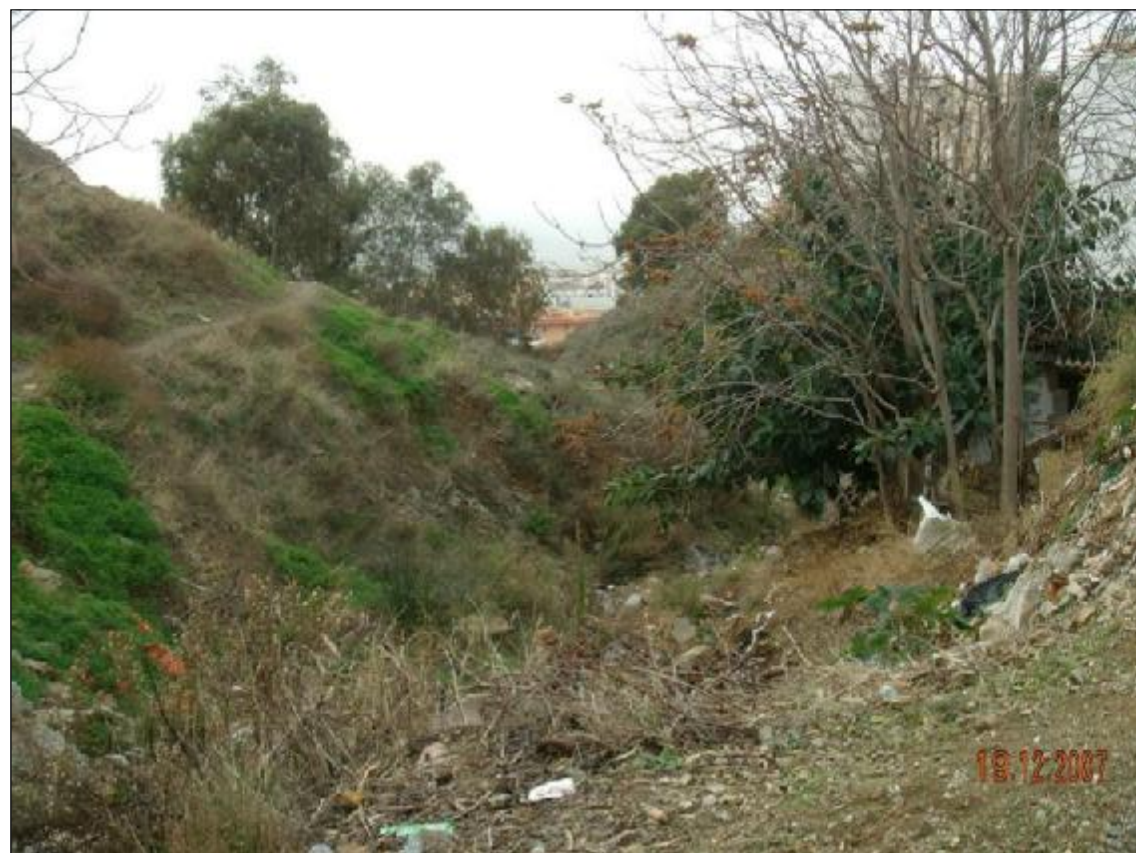
Fotografía nº 7. - Atisbamos todavía la última planta de las singulares viviendas que existen en el entorno de la embocadura. Obviamente miramos hacia aguas abajo.
