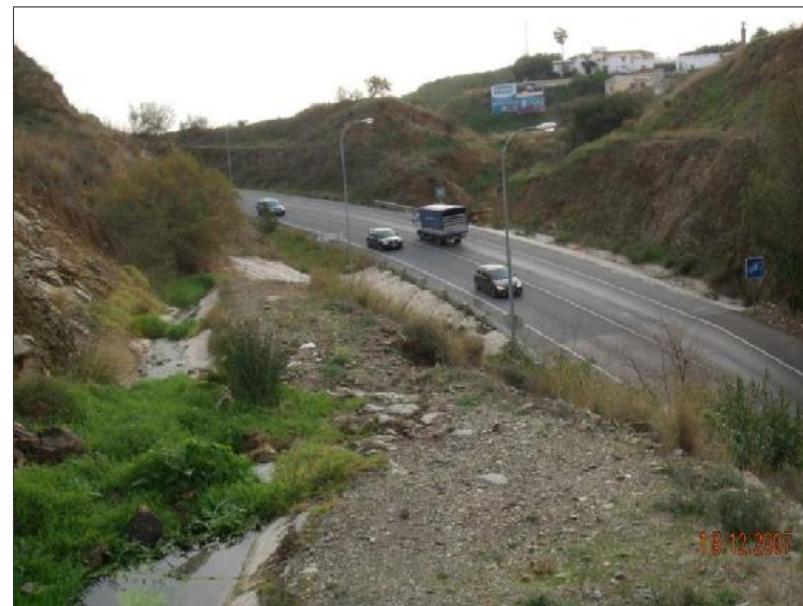
Fotografía nº 20. - La cuneta continúa hacia el ramal antes comentado. Queremos averiguar cual es la dirección por la que continúa. Por donde transita el camión vemos una vaguada que debía ser la continuación de este cauce antes de que se explanara el ramal de acceso a Ciudad Jardín.
