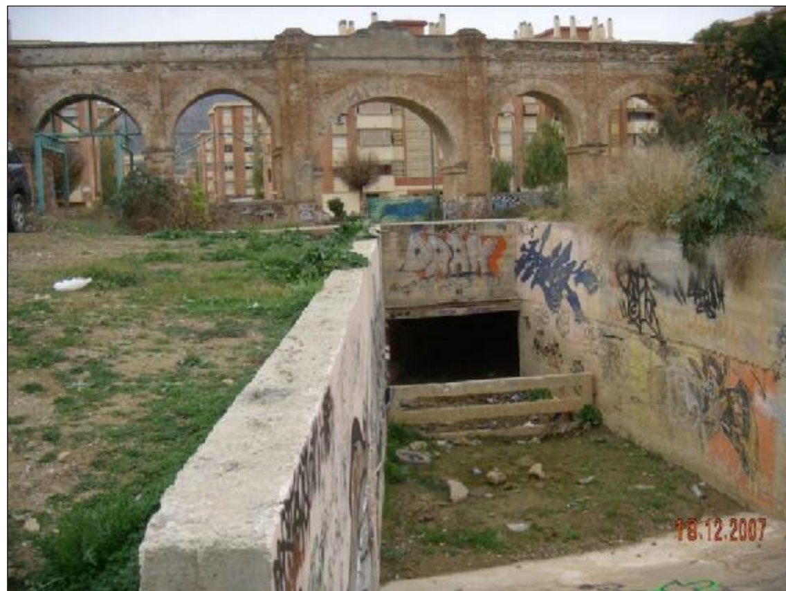
Fotografía nº 1. - En esta primera fotografía vemos la boquilla donde comienza el embovedado del arroyo; comienzo de un marco rectangular con una sección de 2,50x 2,00 m. Detrás vemos el acueducto que recorre una buena parte de esta zona de Málaga.
